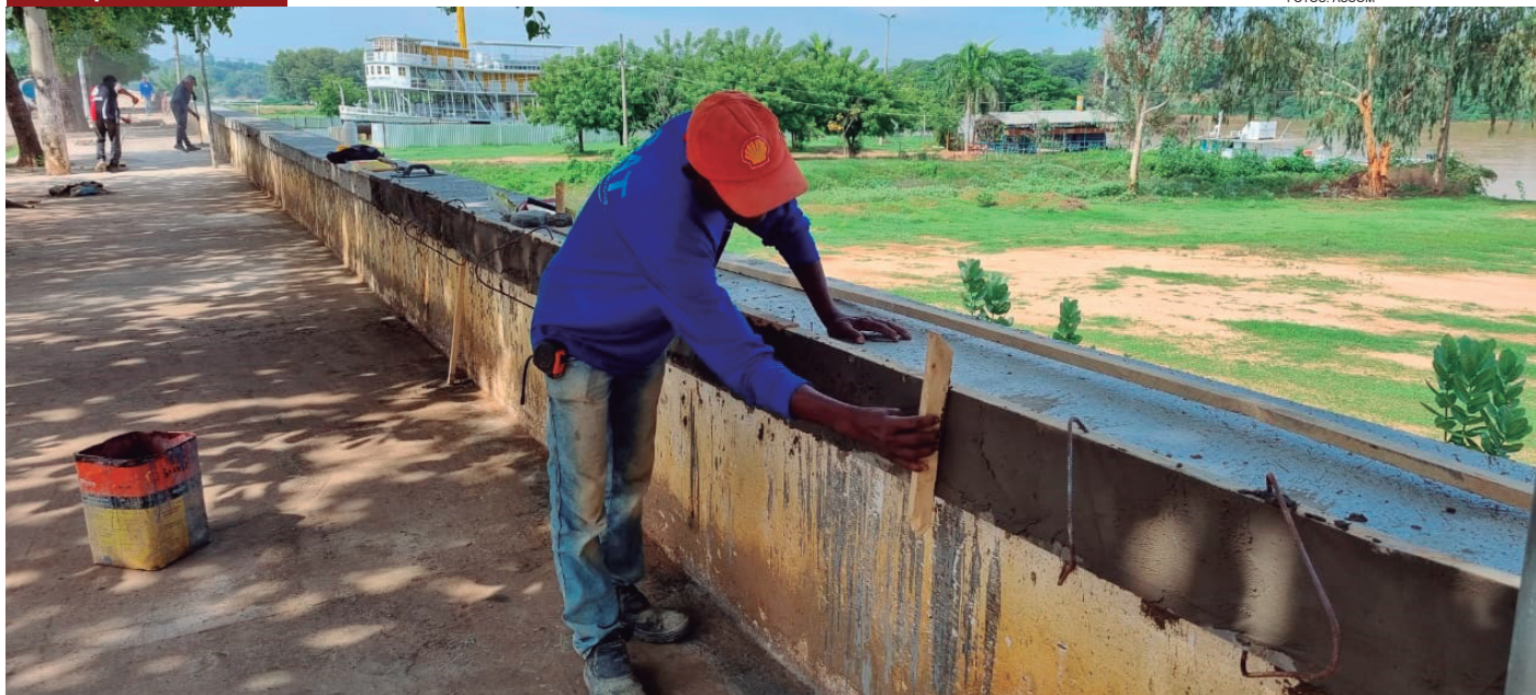
▲ Os reparos realizados na calçada e na mureta do cais, localizado na Avenida São Francisco, à margem do rio que leva o mesmo nome da via, é mais um dos vários serviços que estão sendo realizados em Pirapora
