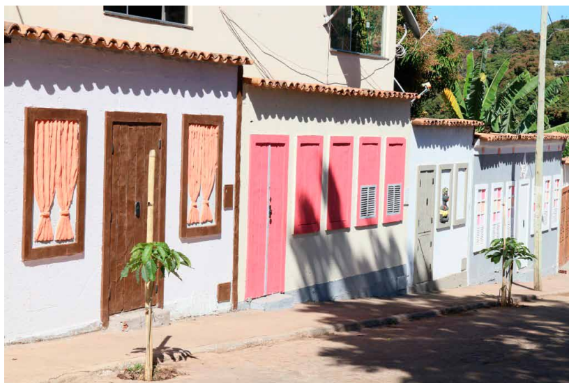
▲ Muros de residências localizadas no Centro Histórico de Grão Mogol recebem obras que imitam fachadas de casas antigas
