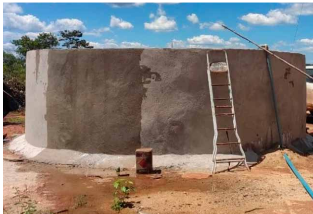
◀ Caixa d'água construída na comunidade rural do Lamarão
